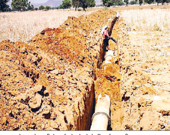
महेन्द्रगढ़। जोहड़ को नहरी नेटवर्क से जोड़ने के बिछाई जा रही पाइप लाइन।
